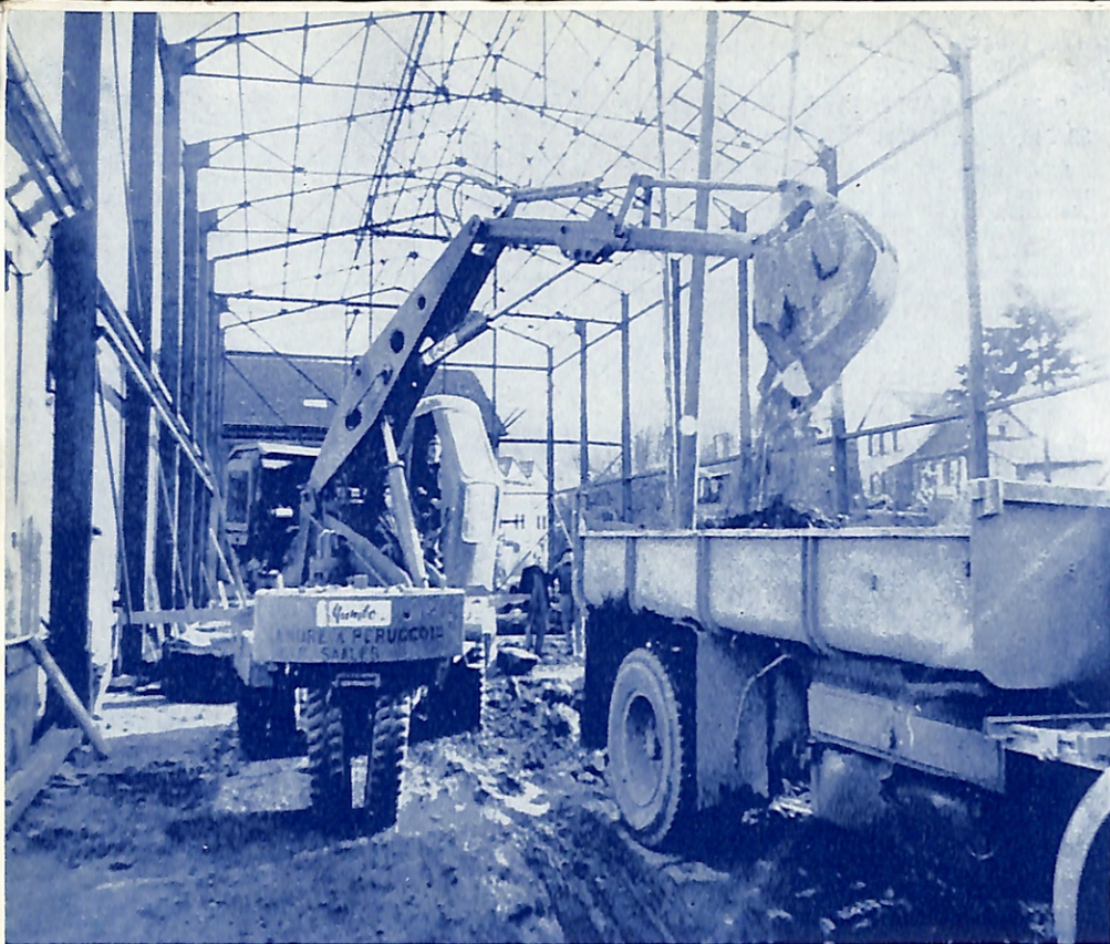
1. 20 janvier : La charpente métallique a été montée en quelques jours.
