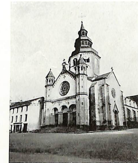
L'église de Senones, démolie pendant la Révolution, en juin 1794, reconstruite en 1829. La tour qui avait échappé à la destruction date du XVI e siècle
