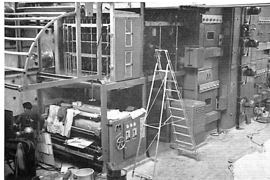
La polymériseuse Montfort en cours de montage.
