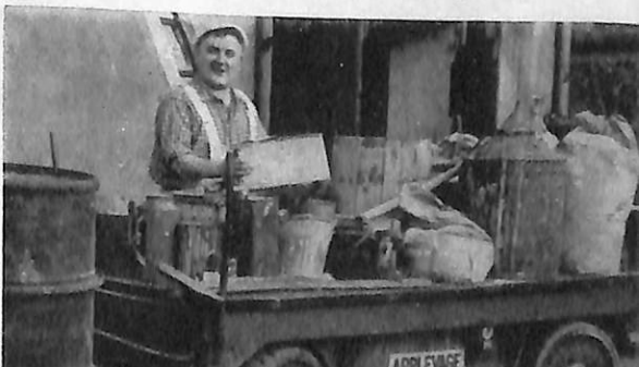
Ci-dessous: En vue d'une meilleure centralisation, l'atelier de Peinture s'est installé dans le local annexe des électriciens. Voici notre sympathique Bechtold-Bourvil en plein déménagement
