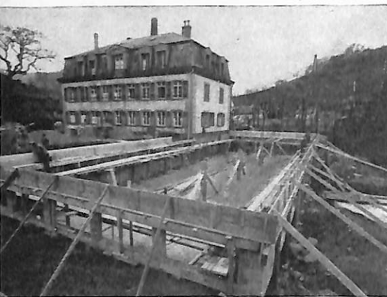
... Les travaux se poursuivent activement.
