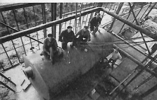
Pendant ce temps la nouvelle chaudière prend petit à petit sa forme définitive.
