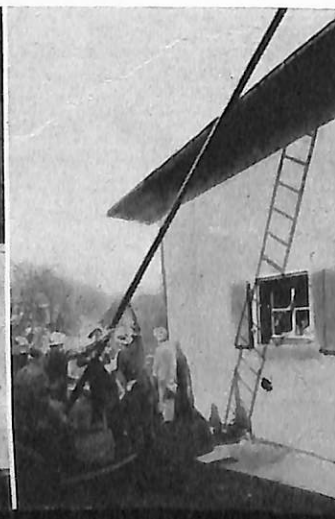
Incendie à la Papeterie Kohler
