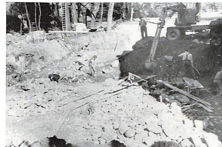
Le même chantier 3 jours plus tard
