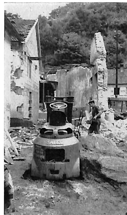
Il a fallu d'abord démolir
