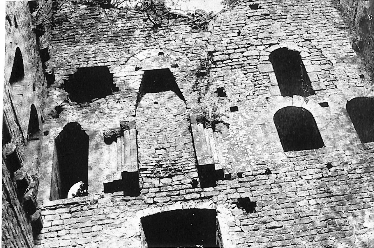
Châteaux d'Ottrott : intérieur de Rathsamhausen. Ancienne salle avec cheminée et colonnette romanes.
